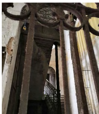
Vista del vano scala
