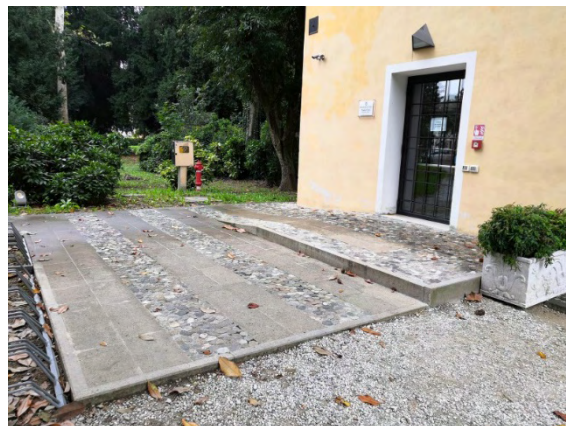
Vista dell'ingresso dedicato a persone disabili, con chiamata
