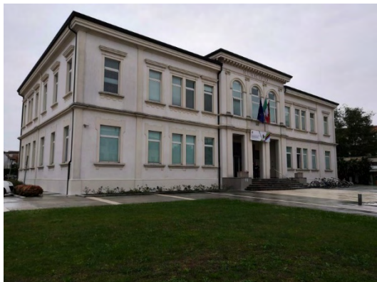
Vista della facciata principale, lato est
