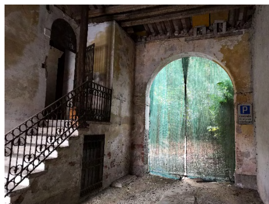
vista del porticato di ingresso
