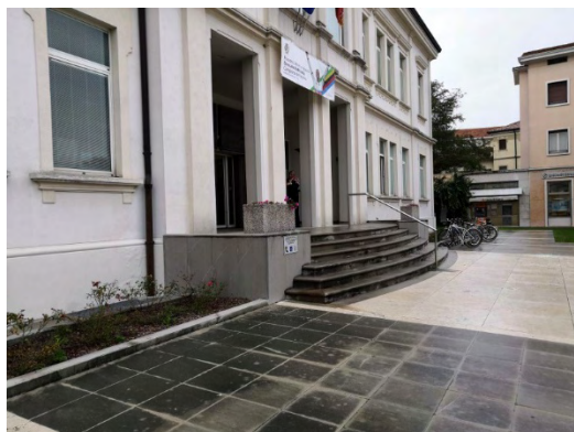
Vista dell'ingresso principale con mancanza di parapetti esterni
