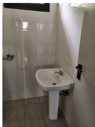
vista del bagno disabili
