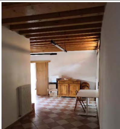
vista dell'interno – ala nord
