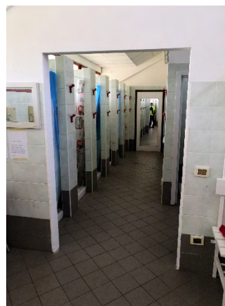
vista della zona docce di uno dei due spogliatoi, non accessibili
