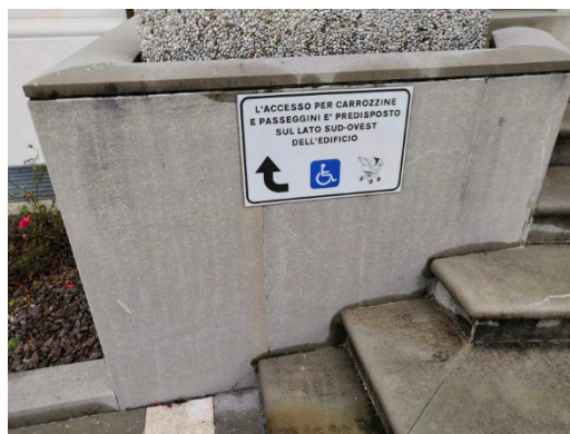
Vista della segnaletica sul lato est
