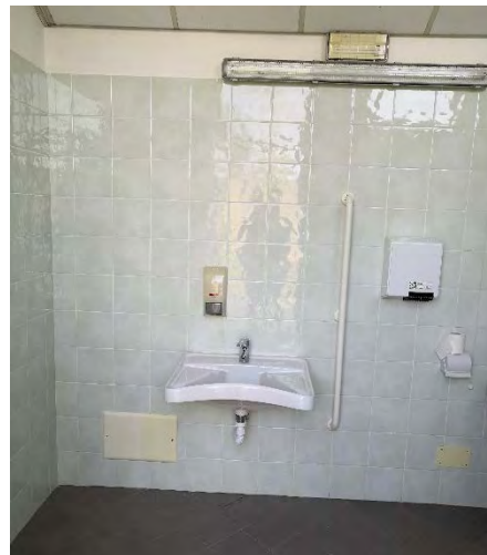
vista del servizio igienico per disabili
