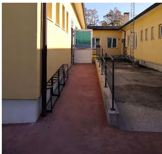
vista della rampa esterna
