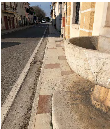
VISTA DI UNO DEGLI OSTACOLI NEL MARCIAPIEDE
