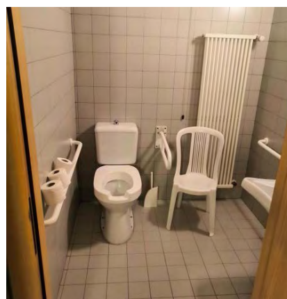
Vista del bagno disabili
