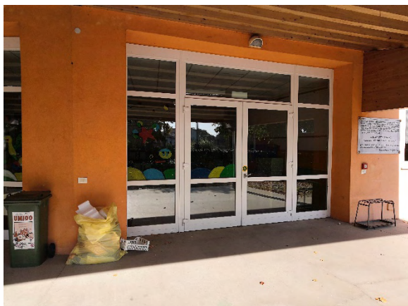
vista dell'ingresso principale
