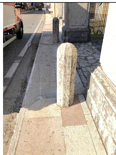
VISTA DI UNO DEGLI OSTACOLI NEL MARCIAPIEDE
