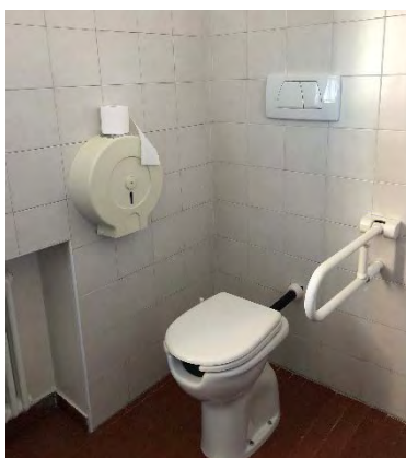
vista del bagno disabili
