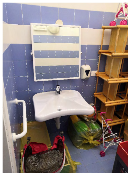
vista del bagno disabili
