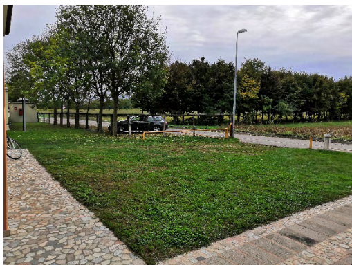
vista degli esterni con gli stalli per il parcheggio, sulla sinistra
