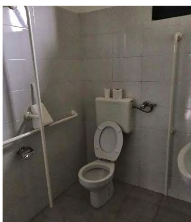
vista del bagno disabili
