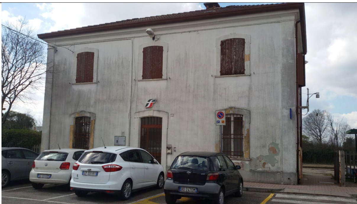
Vista del parcheggio disabili esistente con, sulla destra, la rampa di raccordo sulla destra
