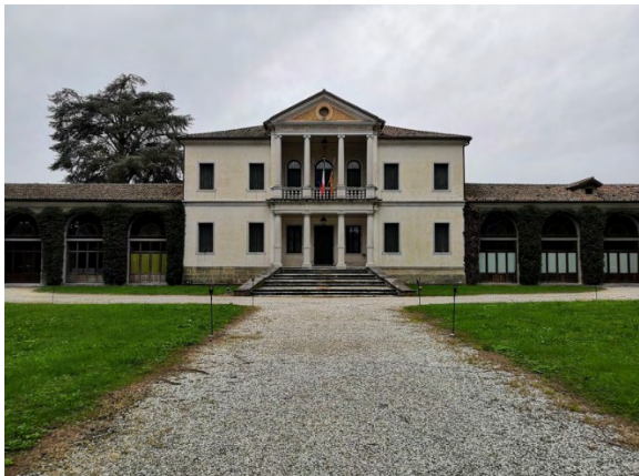
Vista della facciata principale, lato est
