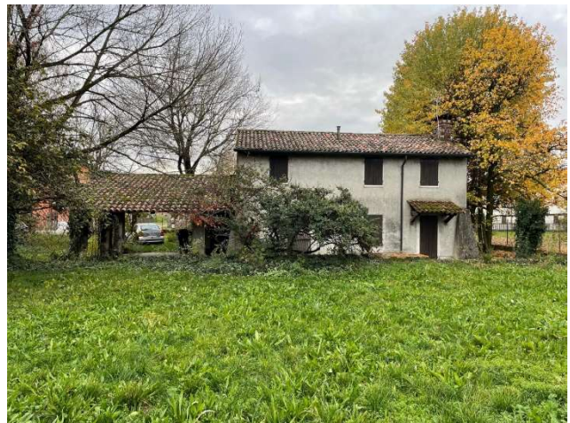
Foto prospetto nord
