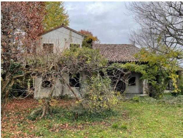
Foto prospetto sud
